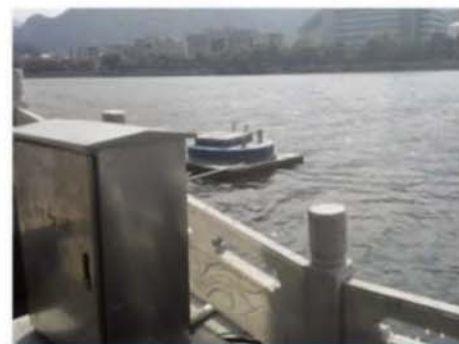
水中安装泵站
