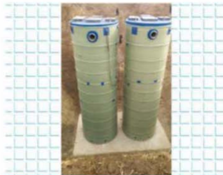
大流量雨水提升泵站
