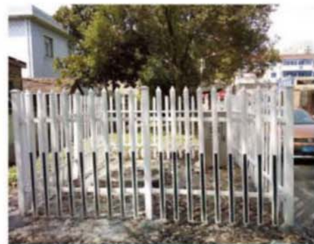
老旧小区改造污水泵站
